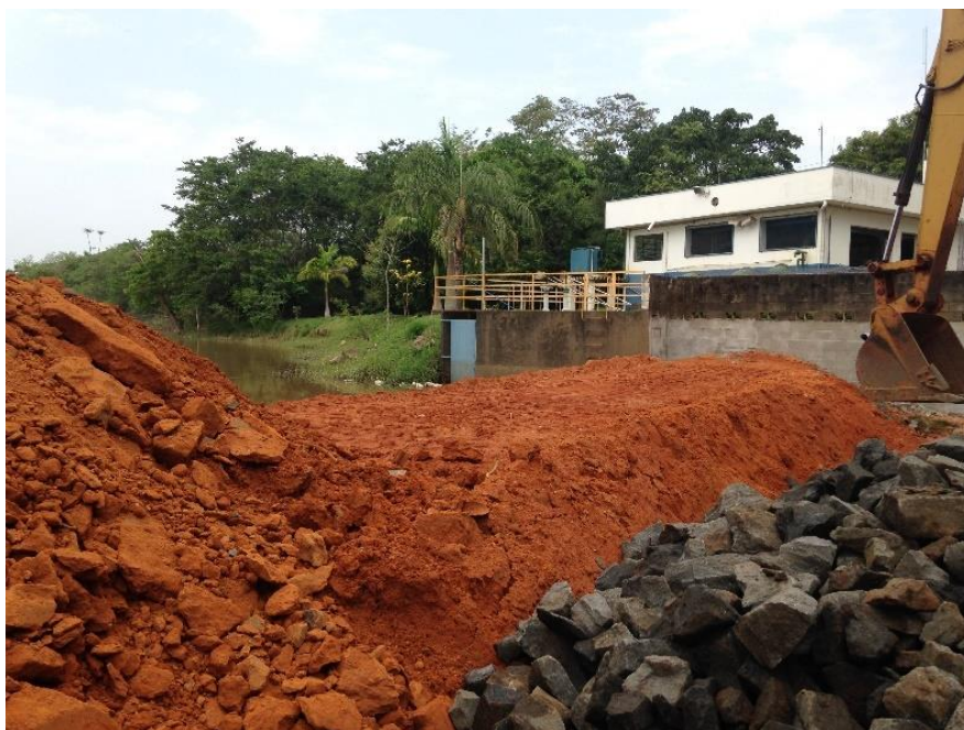
Figura 35. Formação do núcleo de argila compactada e estoque de enrocamento para preenchimento dos gabiões.
