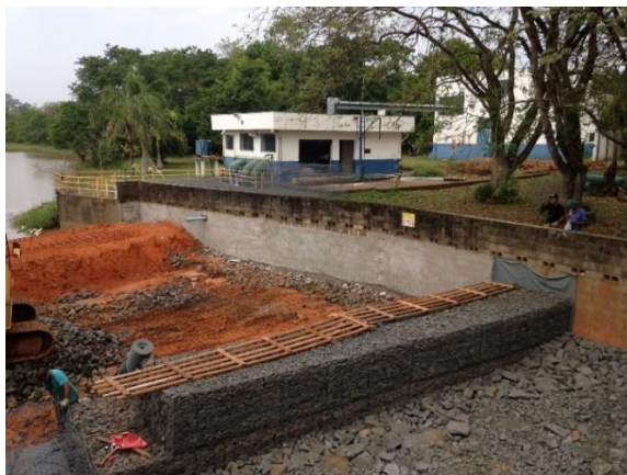
Figura 33. Exeução da barragem de gabião com núcleo de argila compactada no Ribeirão Avecuia – Porto Feliz/SP.
