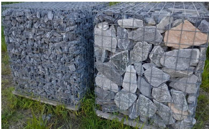
Figura 2 – Gabiões caixas de malha soldada
