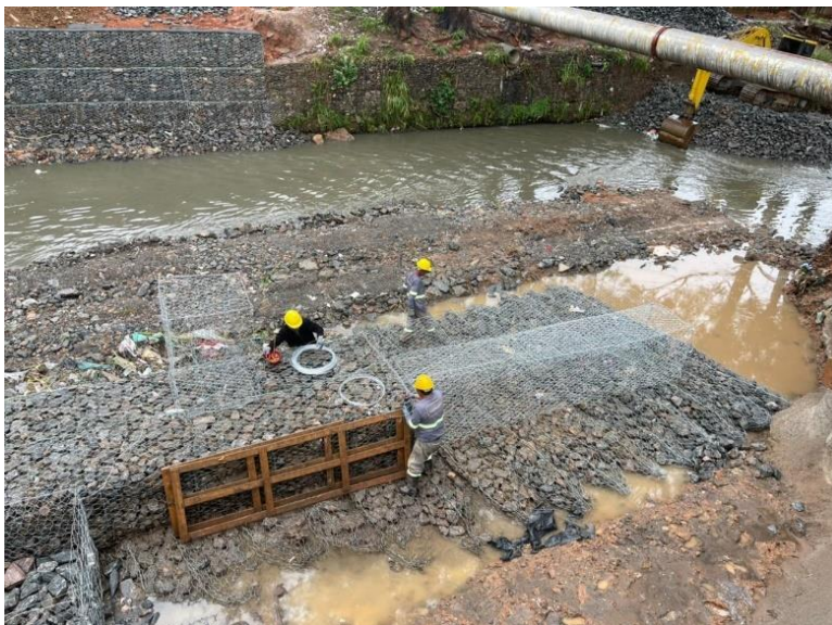
Figura 49. Execução da montagem das caixas referentes ao primeiro nível da contenção – notar a fundação composta por gabiões tipo saco.
