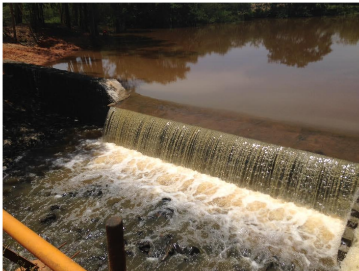
Figura 10. Barragem em operação. O fundo de reservatório é revestido com enrocamento para evitar erosão.
