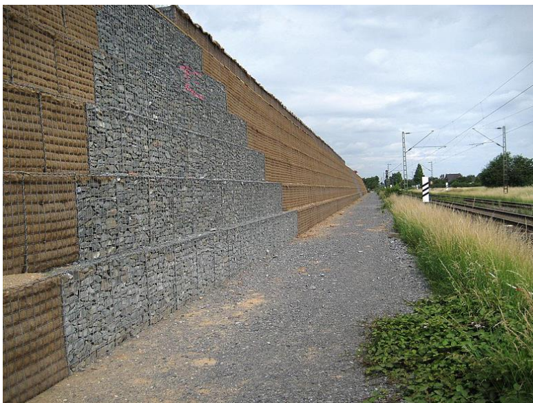
Figura 73 - Gabiões posicionados próximos a ferrovias.
