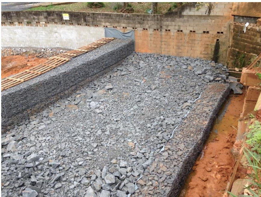
Figura 36. Vista do paramento em gabião concluído, com gaiolas preenchidas e intertravadas.
