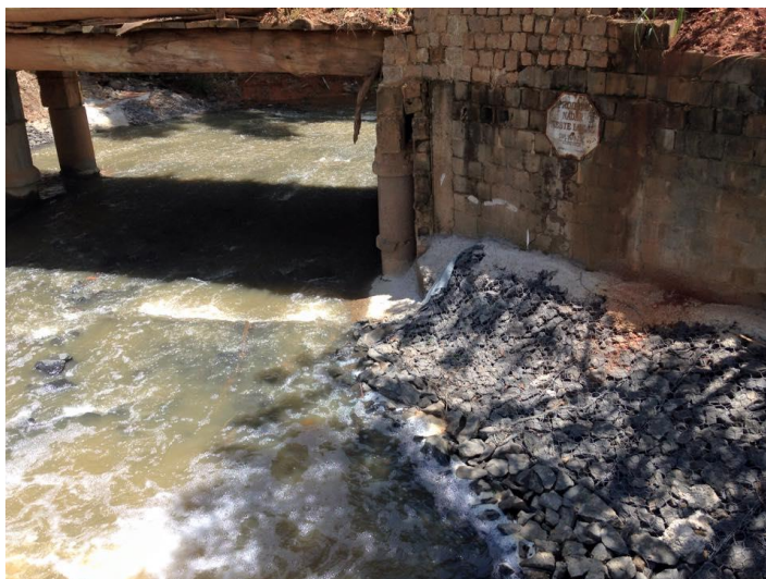
Figura 11. Proteção das margens do ribeirão com enrocamento para evitar erosão.
