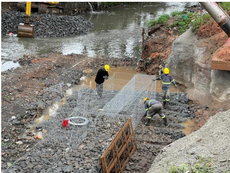
Figura 51. Execução da montagem das caixas referentes ao primeiro nível da contenção – notar a fundação composta por gabiões tipo saco.
