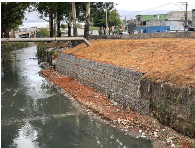
Figura 54. Contenção de margem finalizada.
