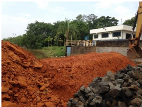
Figura 5. Execução do núcleo impermeável de argila compactada
