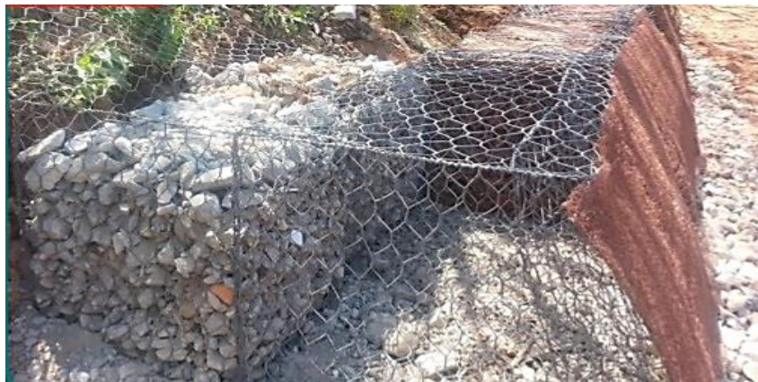
Figura 24. Macsoil® preenchido com Resíduo de construção civil reciclado.
