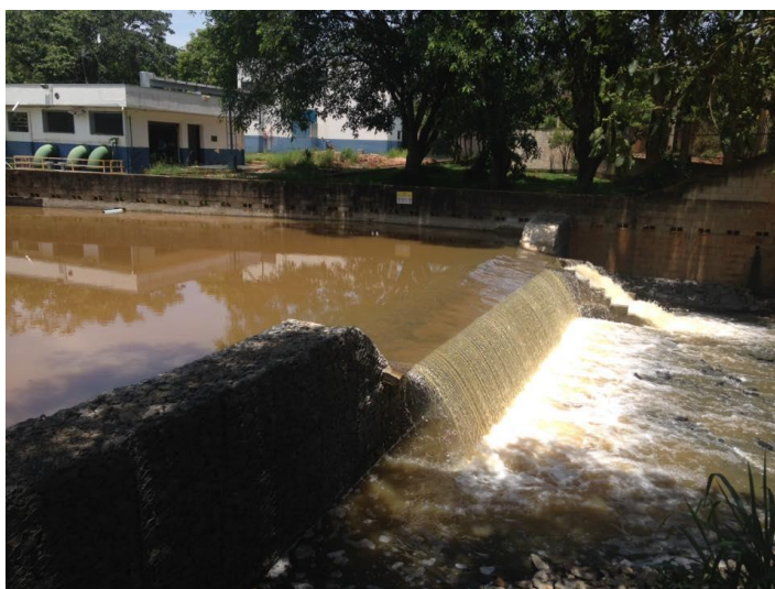
Figura 9. Barragem em operação. Notar vertedouro de centro e escada para peixes.
