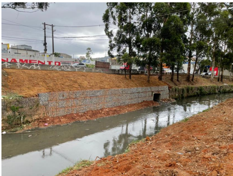
Figura 55. Contenção de margem finalizada.
