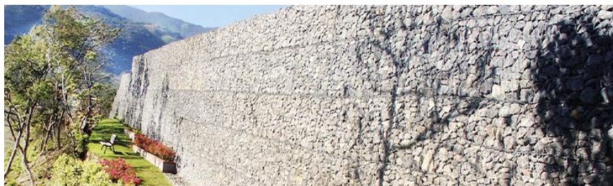
Figura 1- Estrutura de contenção feita com gabião
