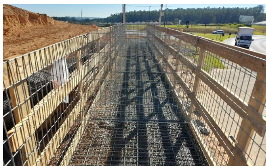
Figura 12. Montagem do dos gabiões com gabarito
