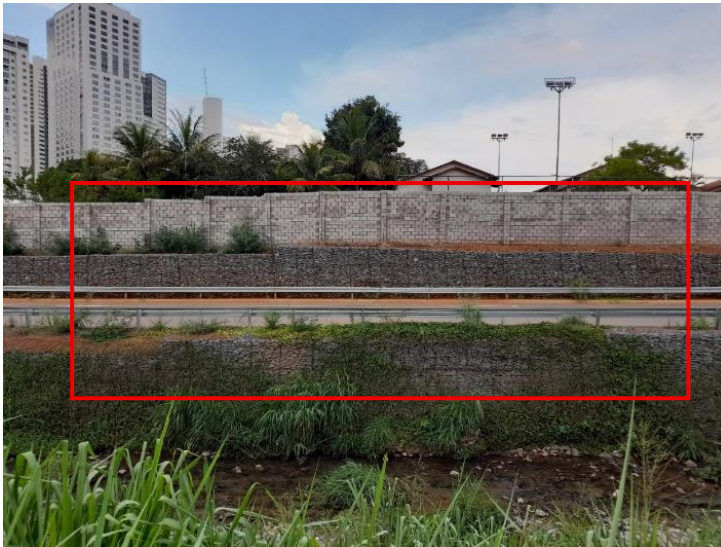
Figura 10. Muro de contenção em gabião.
