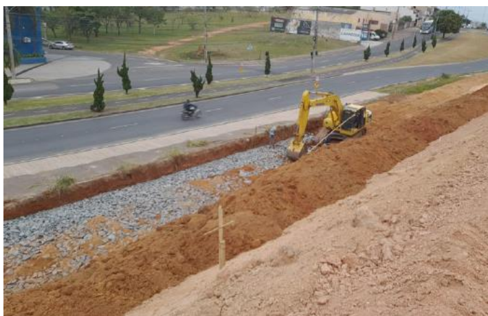
Figura 9. Preparação do terreno do Muro 1
