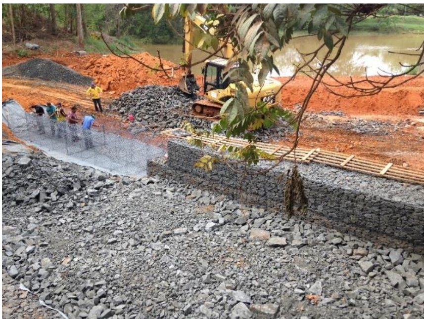
Figura 37. Montagem dos gabiões e preenchimento com enrocamento.
