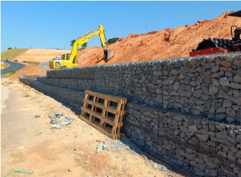
Figura 15. Compactação do aterro.
