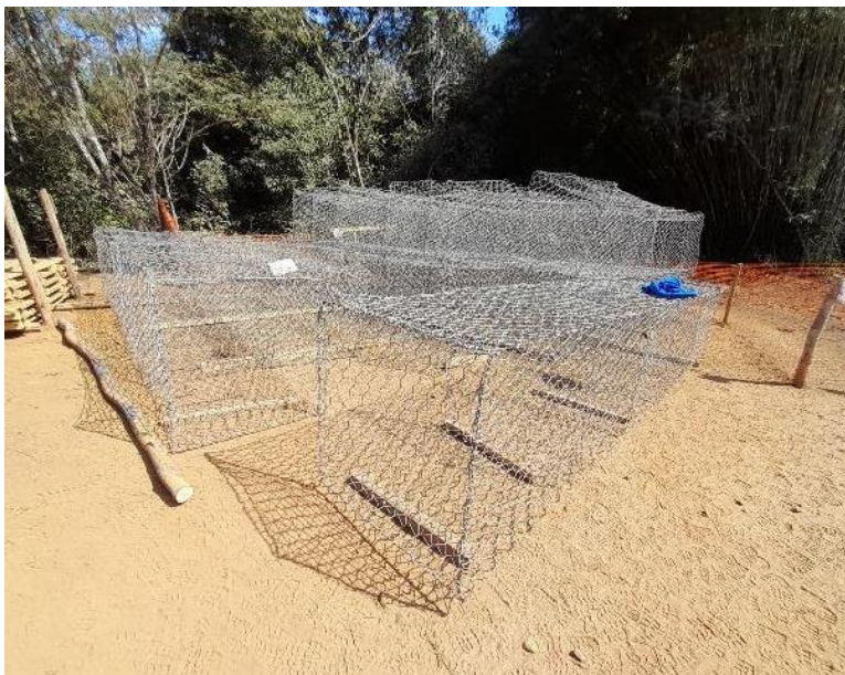
Figura 1 – Gabiões caixa tradicionais
