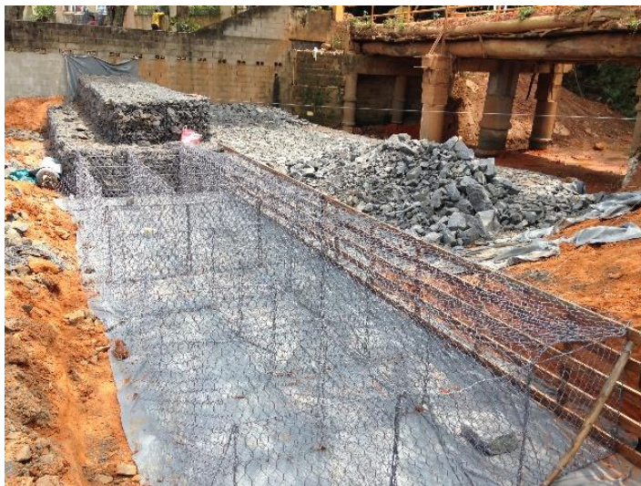
Figura 6. Locação e preenchimento dos gabiões caixa – notar geotêxtil situado na base dos gabiões
