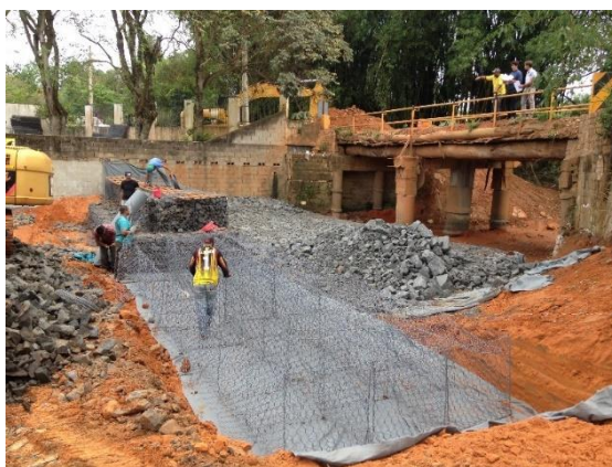
Figura 34. Posicionamento das caixas de gabião sobre manta geotêxtil e início do preenchimento com enrocamento.
