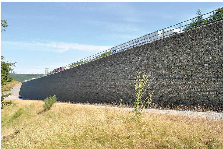
Figura 75 - Gabiões posicionados próximos a rodovias em Frankfurt – Alemanha - além da contenção das margens das vias como elementos acústicos.
