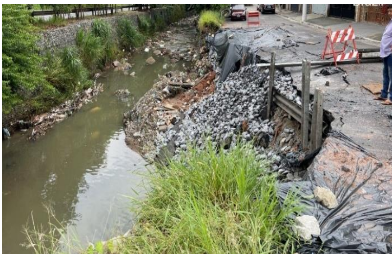
Figura 7 -Vista geral do local e contenção provisória.
