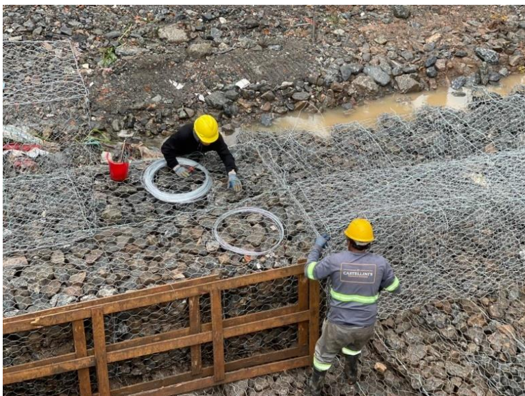
Figura 50. Detalhe da montagem e costura das caixas referentes ao primeiro nível do muro.
