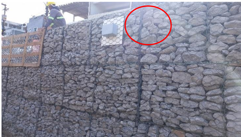
Figura 9 -Dispositivo IoT instalado na contenção
