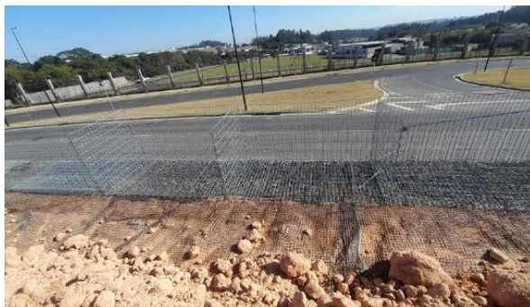
Figura 11. União dos gabiões de malha soldada com conexões em espiral.
