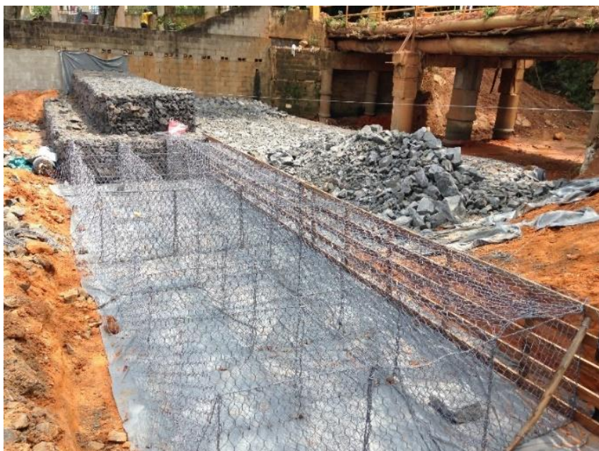
Figura 38. Arranjo das gaiolas de gabião sobre manta geotêxtil antes do preenchimento com pedras.
