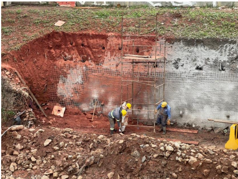
Figura 45. Estabilização provisória do maciço com grampos para execução de contenção de gabião.
