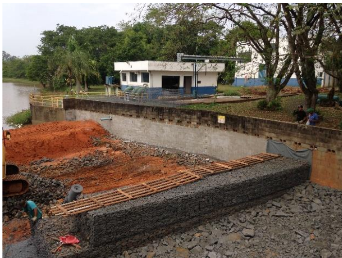
Figura 8. Face de jusante em gabião caixa sendo executada – no espaço entre o aterro e a face de gabião foi executado o núcleo impermeável de argila.
