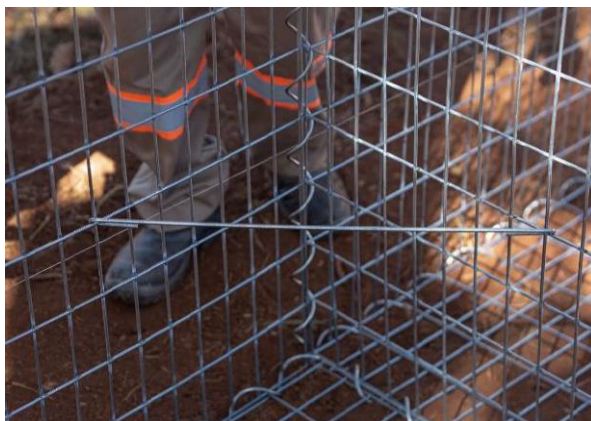
Figura 10 – Conexões dos gabiões eletrosoldados
