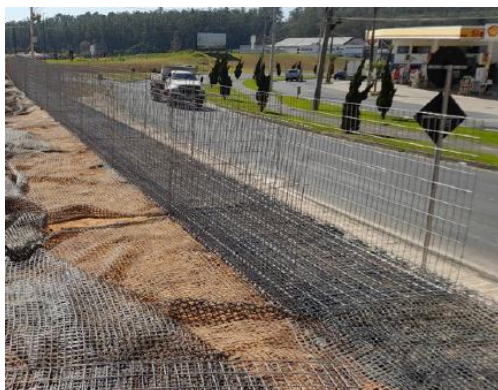
Figura 10. Montagem do gabião com geogrelha.
