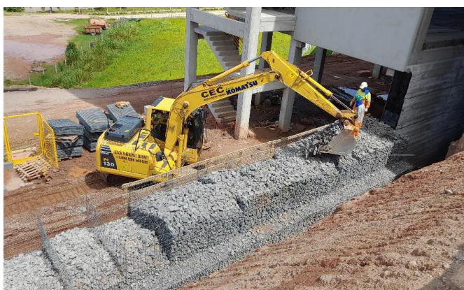
Figura 11 – Preenchimento com pedras dos gabiões eletrosoldados
