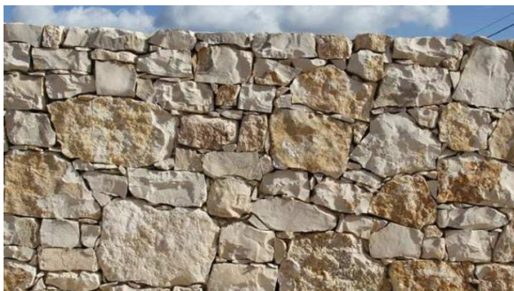
Figura 1. Muro gravidade de pedra seca.
