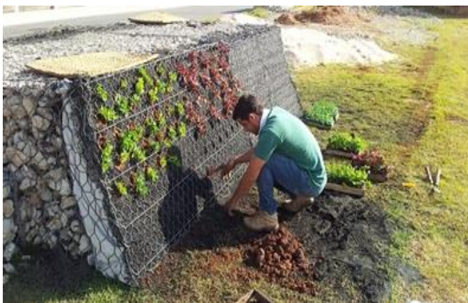
Figura 25. Macsoil® com camada de vegetação introduzida manualmente.
