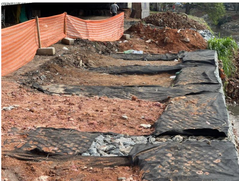
Figura 48. Reaterro de montante executado.
