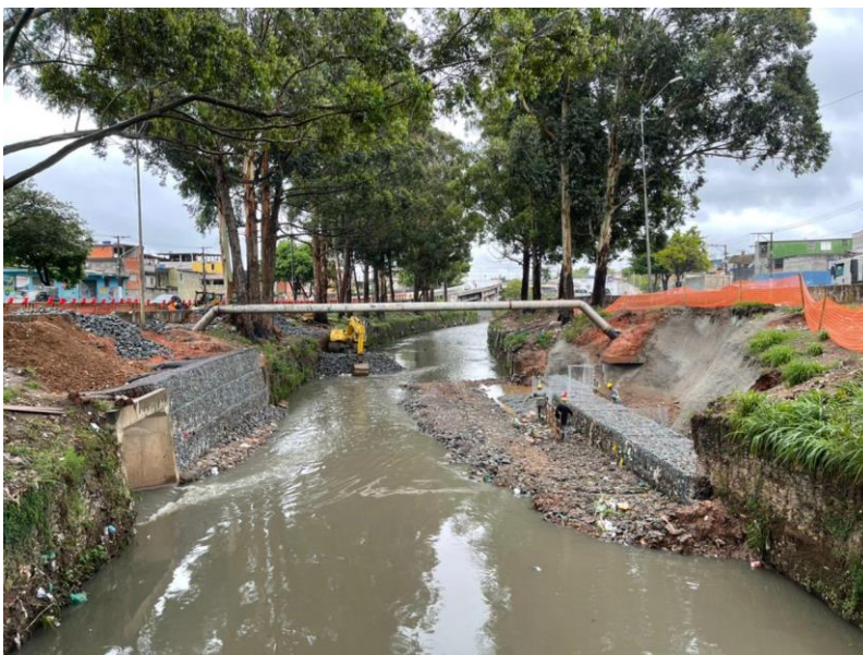
Figura 53. Vista geral da obra em estudos.
