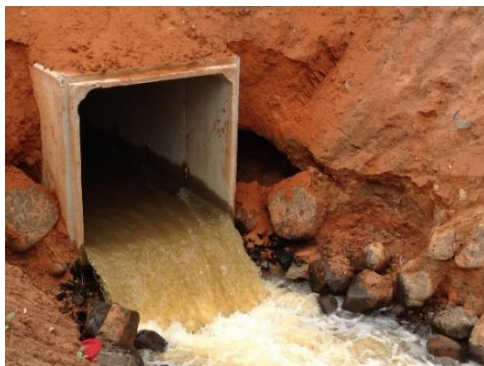
Figura 4. Manilha (1,5 x 1,5m) utilizada para desvio do Ribeirão Avecuia para exexução do barramento.
