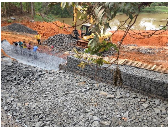
Figura 7. Locação e preenchimento dos gabiões caixa – notar geotêxtil situado na base dos gabiões
