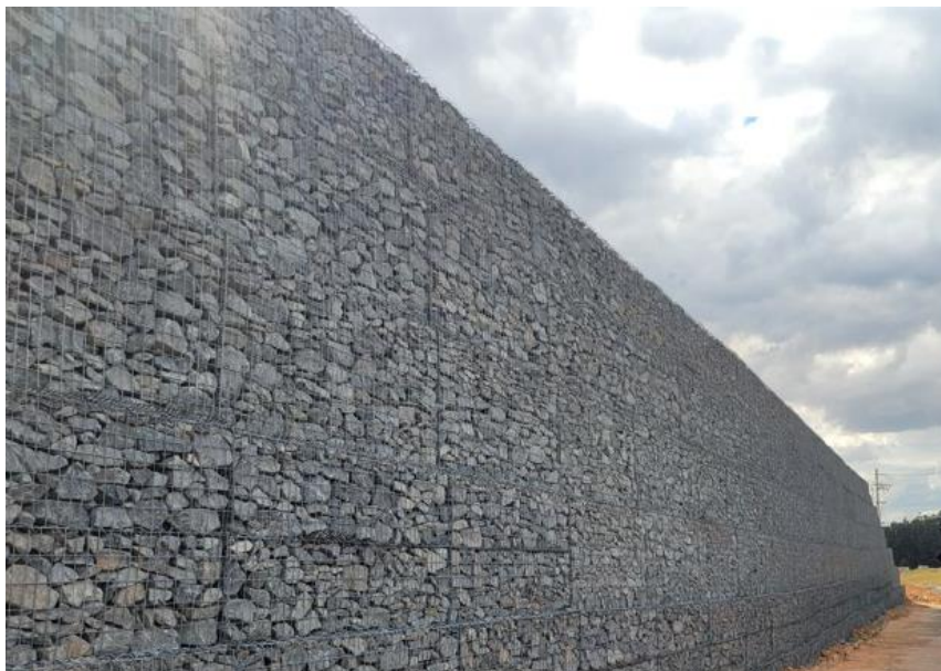
Figura 14. Face do Muro 1
