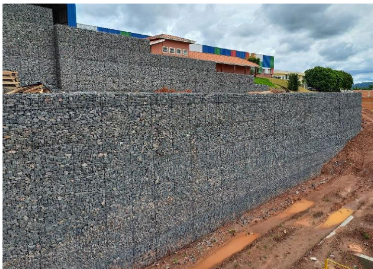
Figura 4 – Muros de contenção da primeira obra com gabiões de malha soldada
