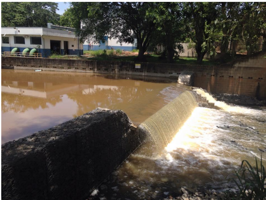
Figura 39. Vista da barragem de gabião concluída, com funcionamento do vertedouro central.
